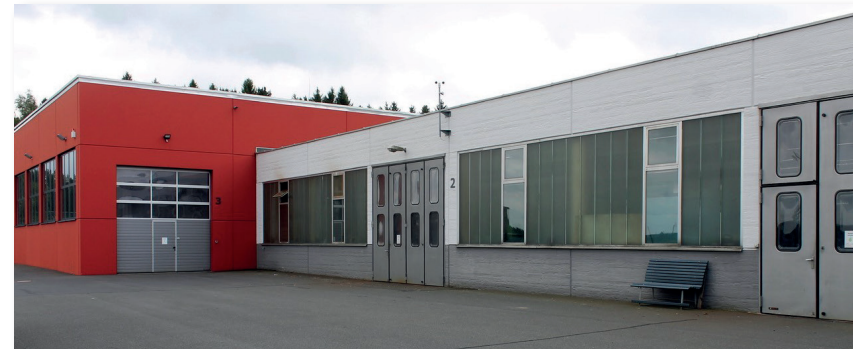
Fertigungshalle vor der Sanierung.
