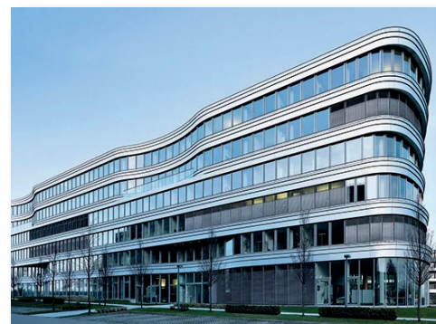
Das Bestandsgebäude vor Sanierung
