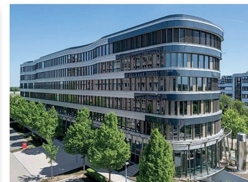
Die neue Fassade nach Sanierung
